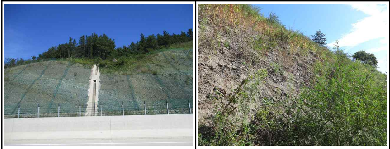
【그림 44.3.1】 상부자연사면 전경
