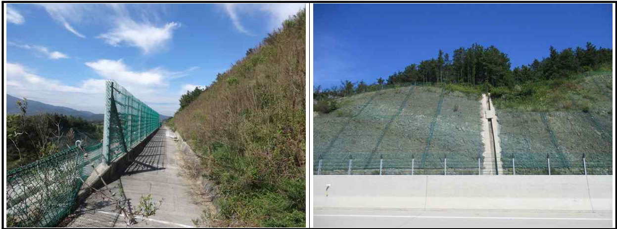
【그림 44.3.3】 배수시설 전경
